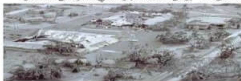
(أ) يؤدي الرماد البركاني الذي يغطي المنطقة إلى تدمير المنشآت، وقد يشكل تدفقًا طينيًا إذا امتزج بالأمطار.
