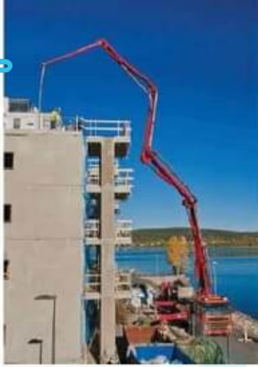
الشكل ٢٠ تستعمل بعض المعدات الهيدروليكية في أعمال البناء.
